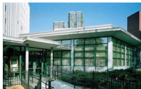
West End Branch (9,700 GSF) 西端分館
